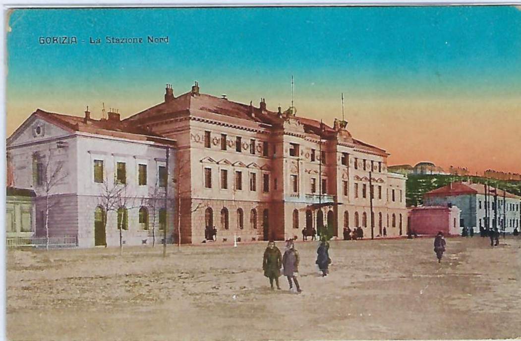
Zunanji izgled postajnega poslopja "Stazione Nord" proti jugu, stavba desno železničarski dom. Poslana iz Gorice, 3.9.1927 v Modeno
